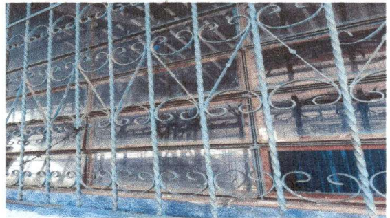
Foto 6: Sustitución de balcones de metal
