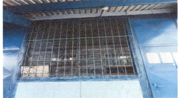
Foto 2: Sustitución de ventana de metal por metal mas vidrios
