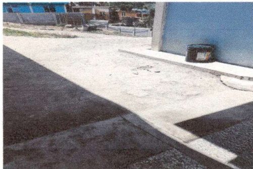
Foto 5: Sustitución de tuberia lineal principal
