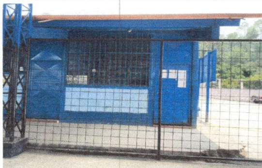
Foto 8: Pintura en muros interiores y exteriores
