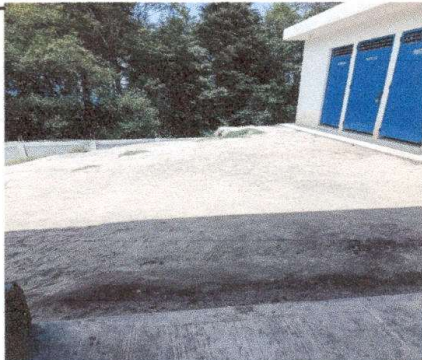
Foto 3: Sustitución de piso de torta de concreto
