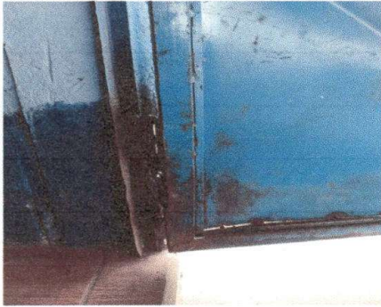
Foto1: Sustitucion de puertas de metal
