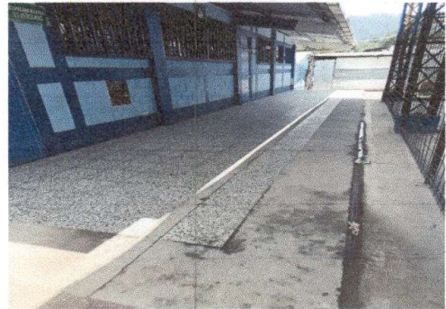
Foto 4: Sustitución de piso de granito por piso cerámico
