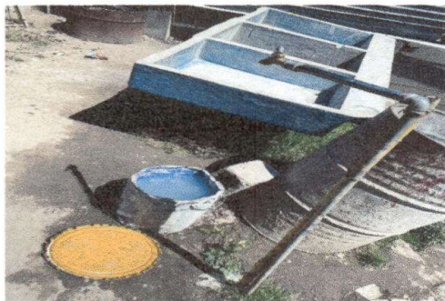
Foto 7: Sustitucion de tuberia lineal principal en chorro
